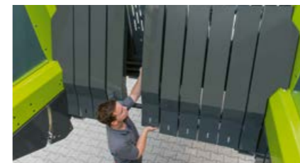
Установка крышки канала.
